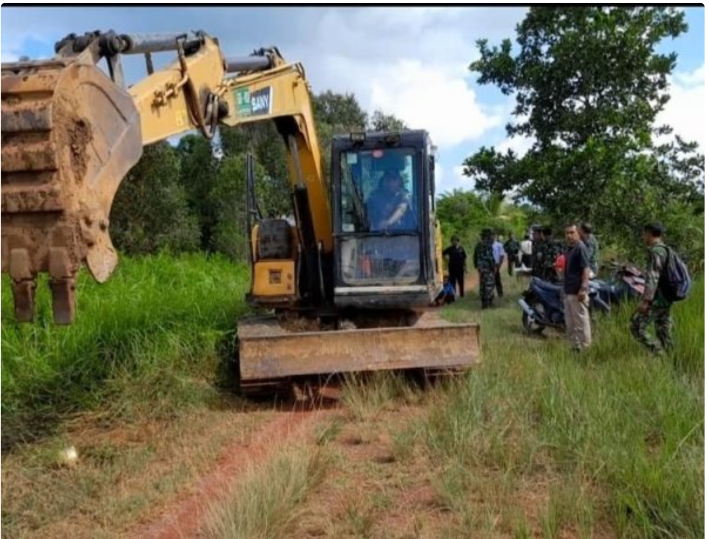
Dandim 1009/Tla, Turunkan Excavator Di Lokasi TMMD
