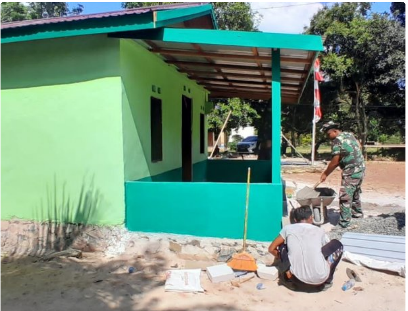
Pengerjaan Rumah Mbah Sandi Hampir Rampung
