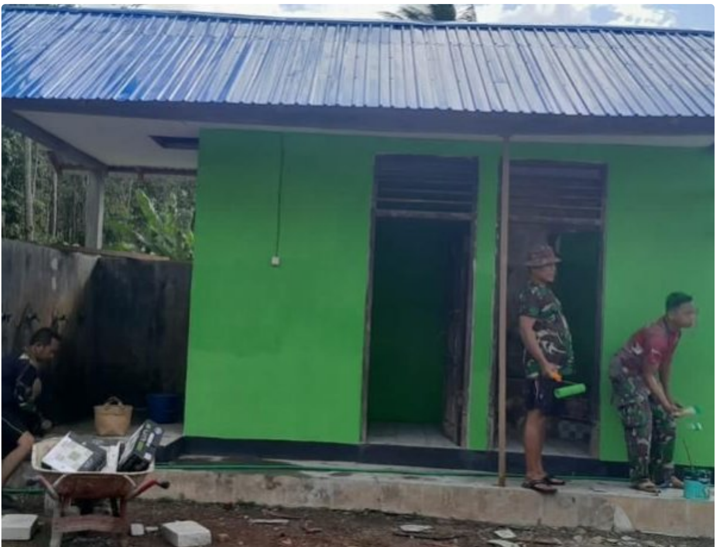
Pengerjaan Sasaran Rehab Masjid, Tinggal Finising
